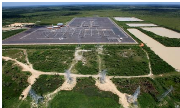
Figura 4. SE 500 kV VHA Obras de Ampliación.
